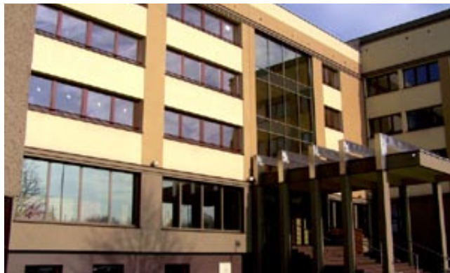
Budynek Rybnickiego Inkubatora Technologicznego przy ul. Jankowickiej 23/25
