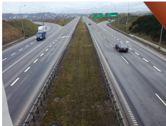
Rys. 4.1 Przykłady wybranych dróg dwu – i wielojazdniowych o różnych przekrojach poprzecznych w Polsce: a) autostrada A1 (A2/2), b) droga ekspresowa S6 (S4/5) c) droga główna ruchu pospiesznego (GP2/2), droga krajowa nr 22, d) ulica główna o ruchu pospiesznym GP2/2 w Gdańsku.
